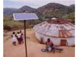
**Du kit de base** (5 à 7 €/W<sub>c</sub> selon installation) incluant un module PV (50 à 100 W), un régulateur de charge, une batterie 12 V et quelques appareils (lampes fluocompactes, TV et radiocassette)
