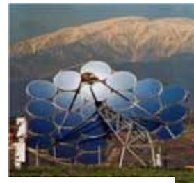
Exemple CNRS Odeillo (France) : Générateur Stirling 10 kWe avec capteur parabolique de 8 m de diamètre
