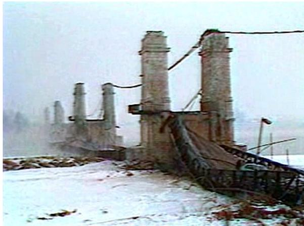
FIGURE 2.10 – Le pont de Sully-sur-Loire après sa rupture brutale du 16 janvier 1985
